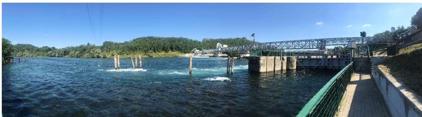
La diga traversa della Miorina sul fiume Ticino sub-lacuale a Golasecca (VA), gestita dal Consorzio del Ticino, Milano, ripresa da valle, con risalto sulla Conca di navigazione gestita da AIPo, Parma.
